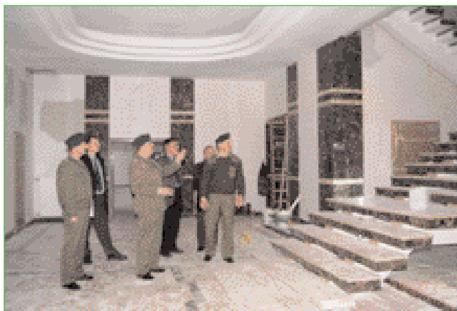
Szef logistyki nadzoruje przebieg prac remontowych
